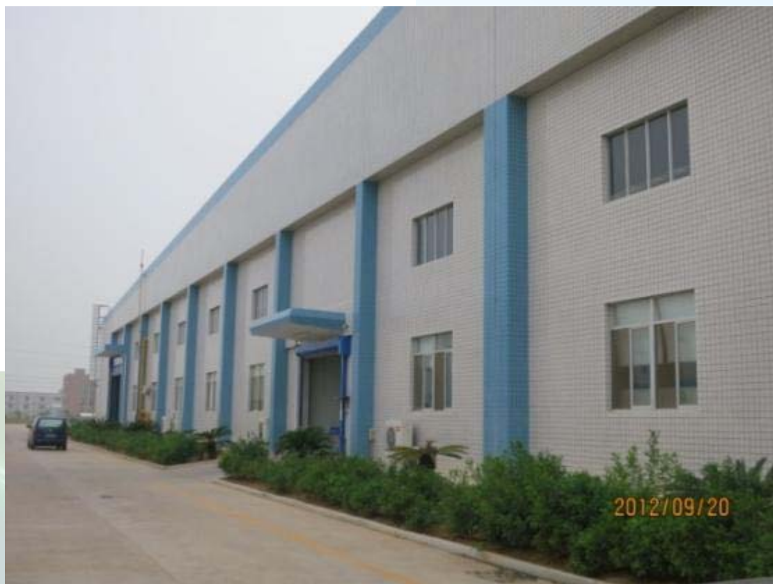
第一車間廠房(第一期)外觀
