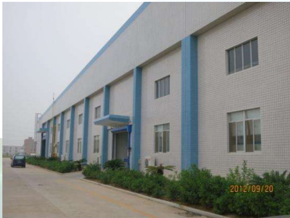
第一車間廠房(第一期)外觀
